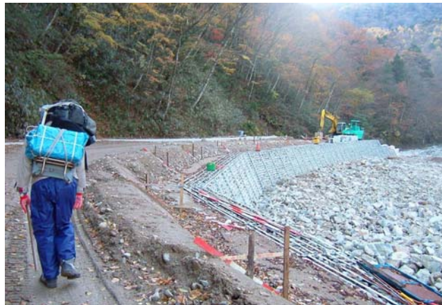
釜沢での工事現場二つ ①下部の砂防ダム工事。今年作業道340mの敷設だけ ②崩壊斜面の治山工事
